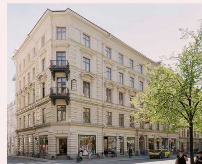
BRYGGMÄSTAREN 5 KUNGSGATAN 53, GAMLA BROGATAN 30-32
