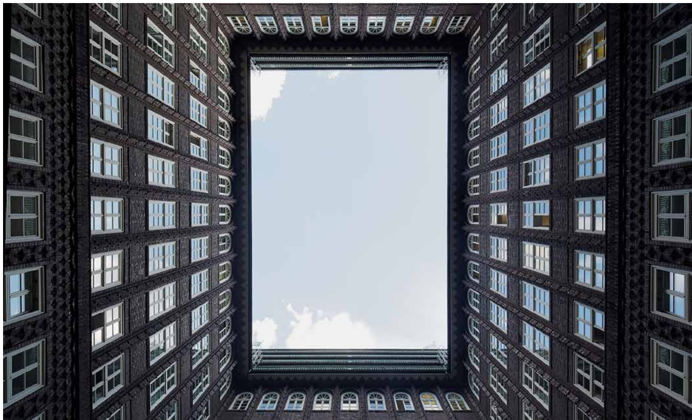
BYGGNADEN TÄCKER TVÅ KVARTER OCH HAR TVÅ STORA INNERGÅRDAR. DEN UPPFÖRDES AV 4 000 ARBETARE PÅ TVÅ ÅR, MED FEM MILJONER TEGELSTENAR OCH 750 JÄRNVÅGSMOTTOR CEMENT.
