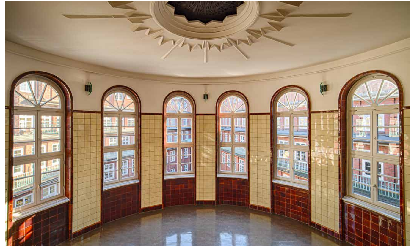
DEN HAR GENOMGÅTT TVÅ STORA RENOVERINGAR, EN EFTER KRIGET OCH EN PÅ 80-TALET. MYCKET TACK VARE SIN FLEXIBLA PLAN HAR HYRESGÄSTERNAS FÖRÄNDRADE KRAV KUNNAT MÖTAS UTAN SVÅRA INGREPP.
