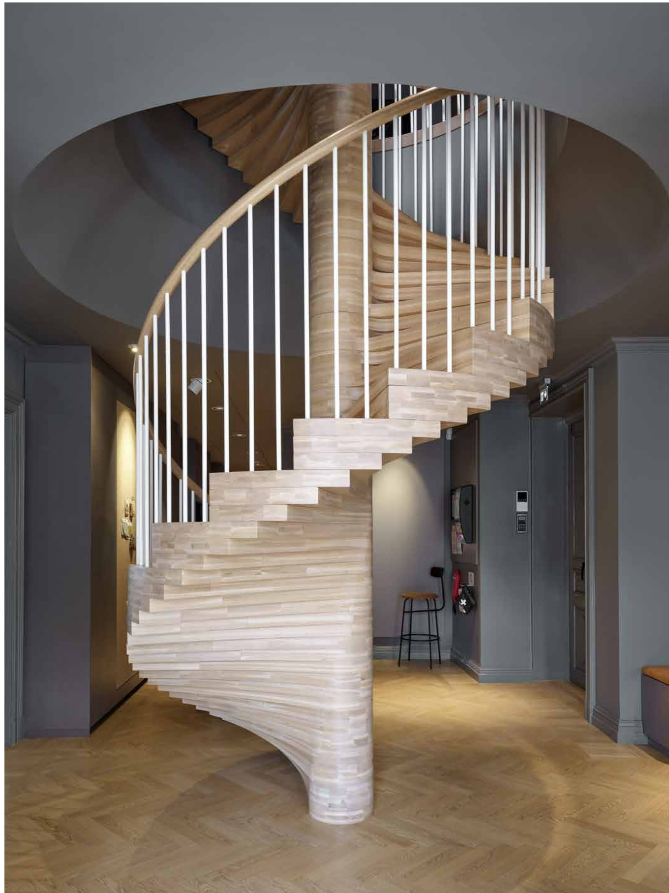
I PILEN 18 FÖRENADES DE TVÅ KONTORSVÅNINGARNA MED EN SKRÄDDARSYDD SPIRALTRAPPA I LÅTT PIGMENTERAD EK. ETT SAMTIDA TILLÄGG SOM ANSLUTER TILL DE URSPRUNGLIGA MATERIALVALEN I HUSETS GOLV OCH SNICKERIER.
