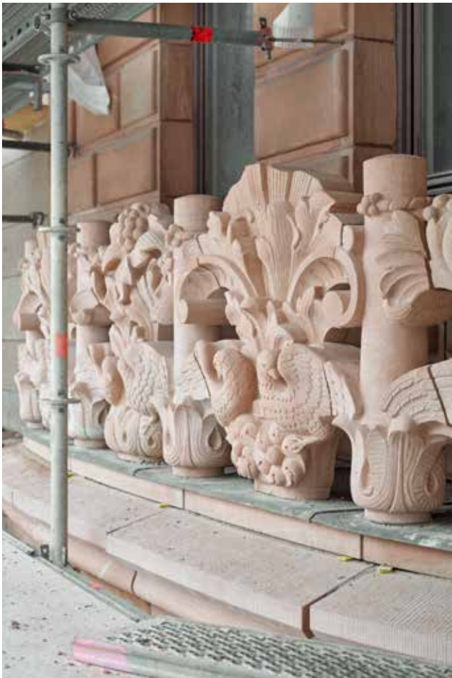
NYHUGGNA BALUSTRADER I ORSASANDSTEN HAR JUST ANLÄNT FRÅN STENHUGGERIET I HANNOVER TILL DET DAVIDSONSKA HUSETS FASAD.
