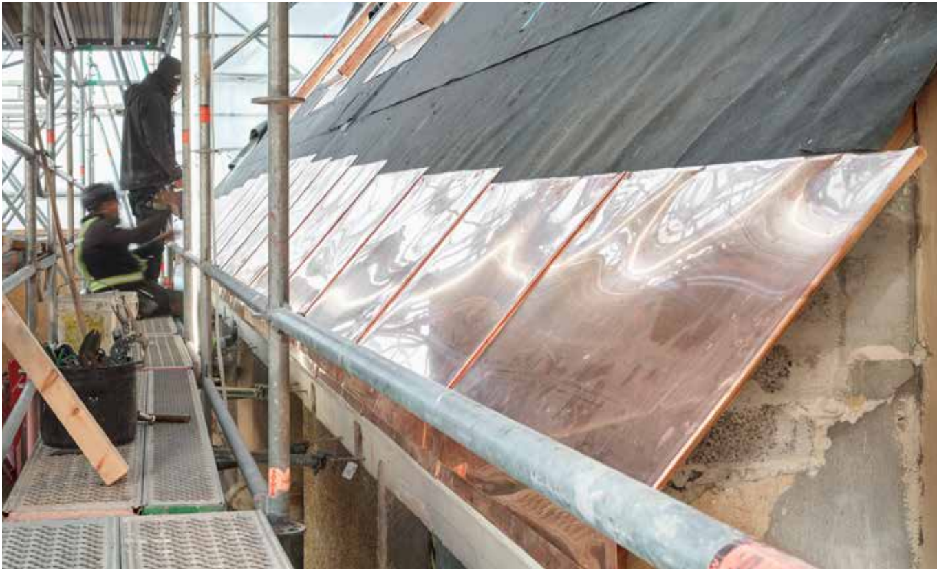
NYA VOLYMER FÖRSES FÖRSTÅS MED ANTIKVARISKT KORREKTA KÖPPARTAK ISTÄLLET FÖR DE MÅLADE PLÅTTAK SOM SENTIDA PÅBYGGNADER HADE VID ARBETETS BÖRJAN.
