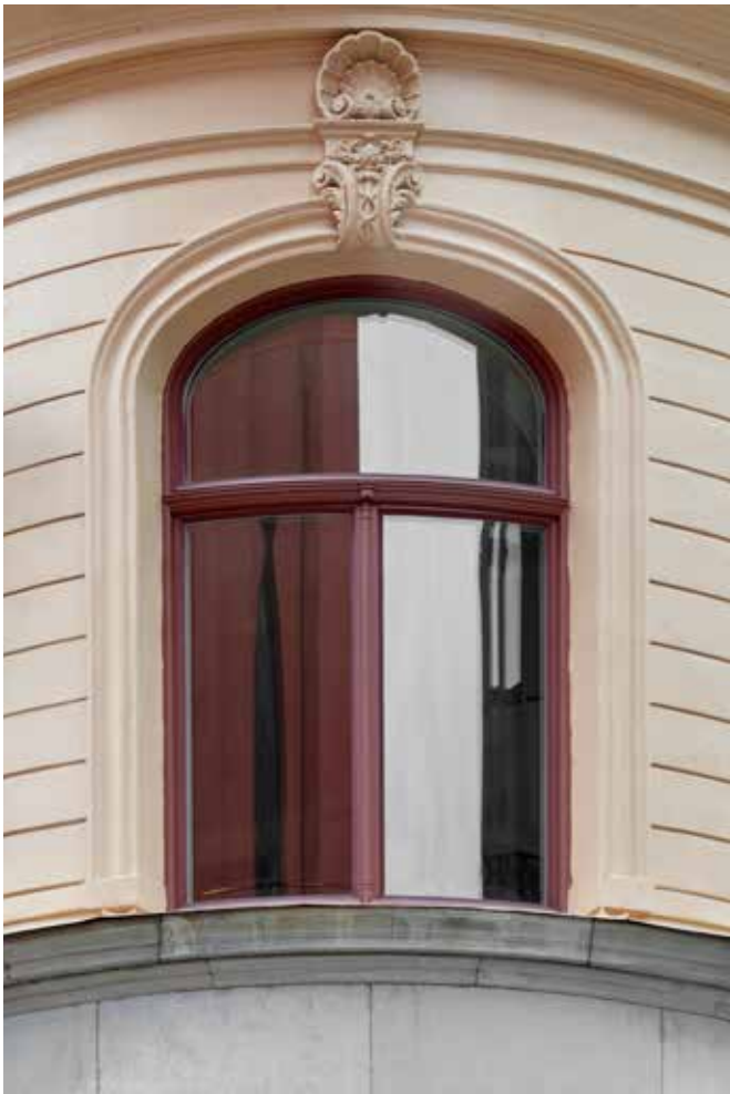
ETT AV DE ÅTERSKAPADE ORIGINALFÖNSTREN I JAKOBS TORG 3, TILLVERKADE AV SENVUXEN FURU FRÅN BURTRÄSK OCH ETT LAGER HÖGBESTÄNDIG OCH KLIMATSMART ACCOYATRÄ YTTERT.
