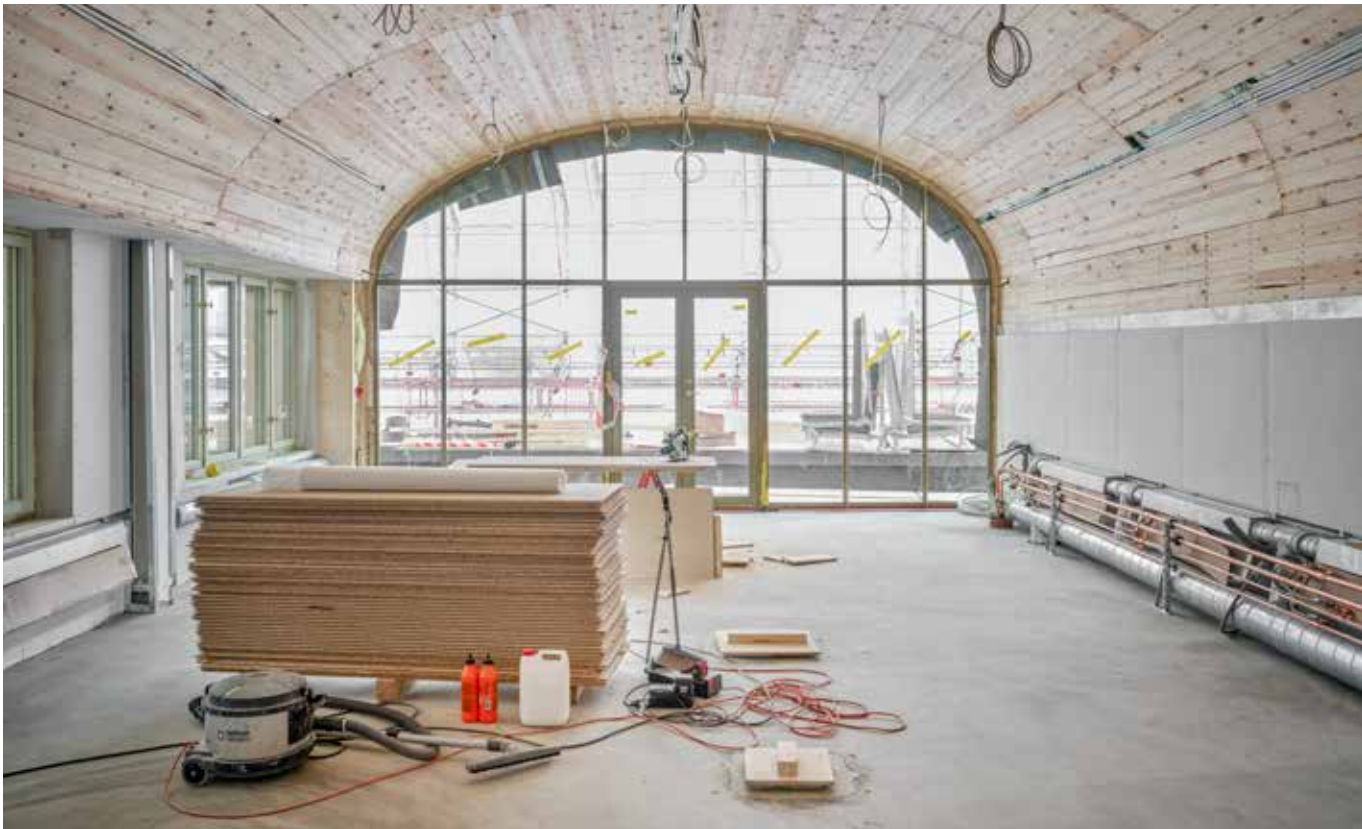
MÖTESRUM MED EN LITEN TERRASS I DE NYA VÅNINGARNA MOT JAKOBSGATAN. TAKLANDSKAPETS VÄLVDA FORMER GÅR IGEN I INTERIÖREN.
