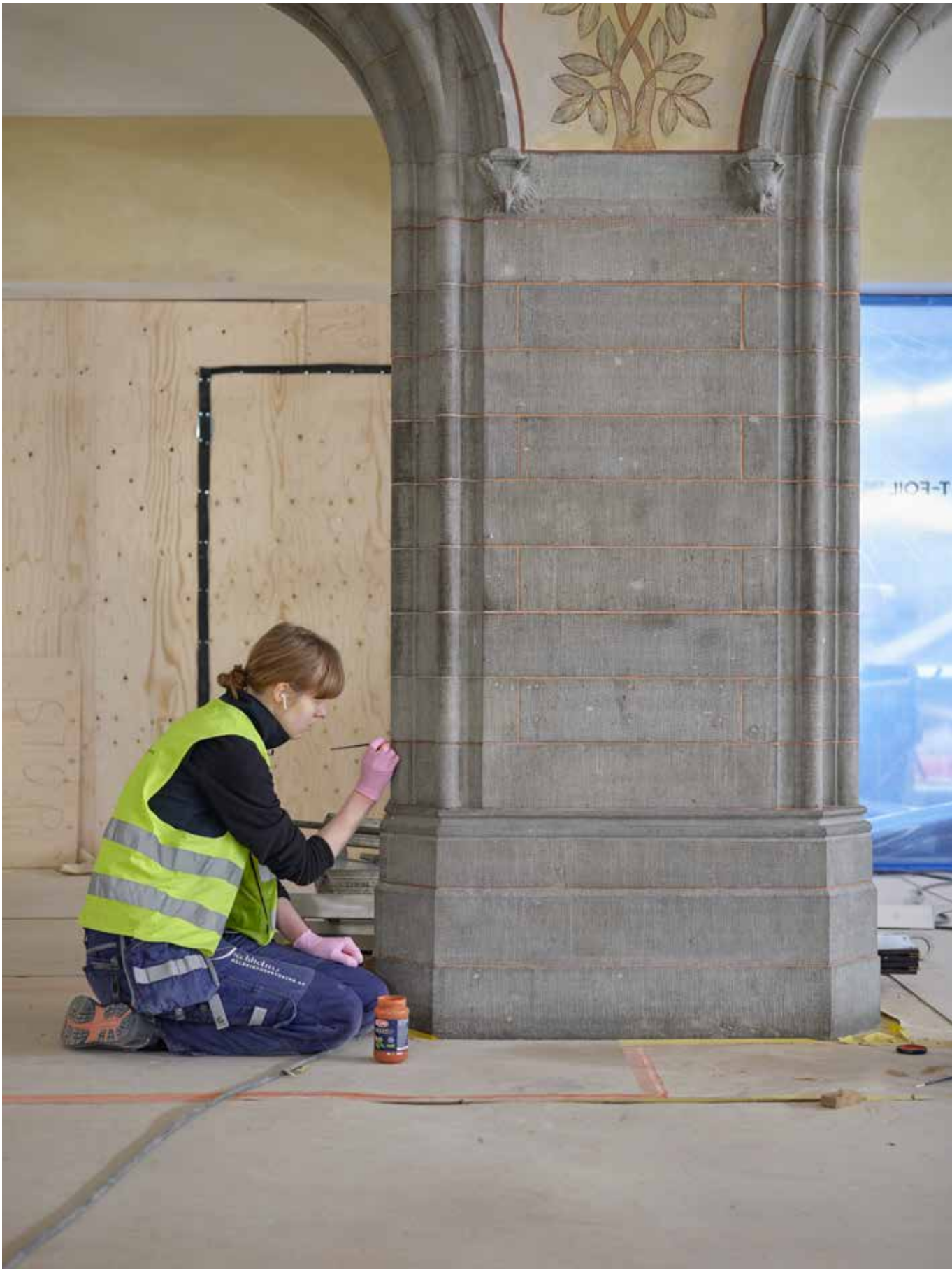
EN RESTAURERARE RENGÖR STENEN OCH BÄTTRAR PÅ FÖGFÄRGEN I DEN RIKT UTSMYCKADE BANKHALLEN I GUSTAV ADOLFS TORG 16. HUGGNA FABELDJUR OCH MÅLADE VÄXTER PYSSLAS OCKSÅ OM.
