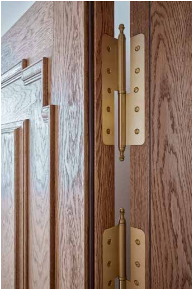
NÅR NYA KOMMUNIKATIONER SKAPADES MELLAN HUSEN FANNS INTE ALLTID EN GAMMAL DÖRR SOM KUNDE ÅTERVINNAS. MEN DET GÅR ALLTID ATT TILLVERKA EN I SAMMA STIL OCH I SAMMA MASSIVA EK SOM ORIGINALET.
