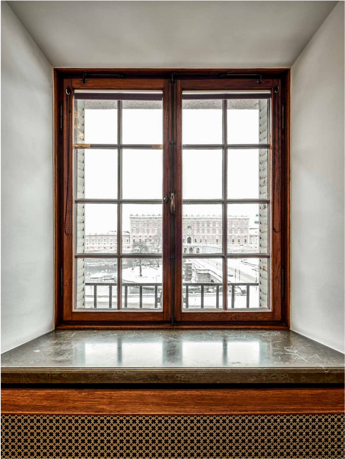
I JAKOB MINDRE 11 ERBJUDER DE DJUPA FÖNSTERBÄNKARNA AV KALKSTEN PLATS ATT SLÅ SIG NER OCH TITTA PÅ SVERIGES STÖRSTA TRÄBYGGNAD, MED INRAMNING AV FÖNSTERBÄGAR I EK.
