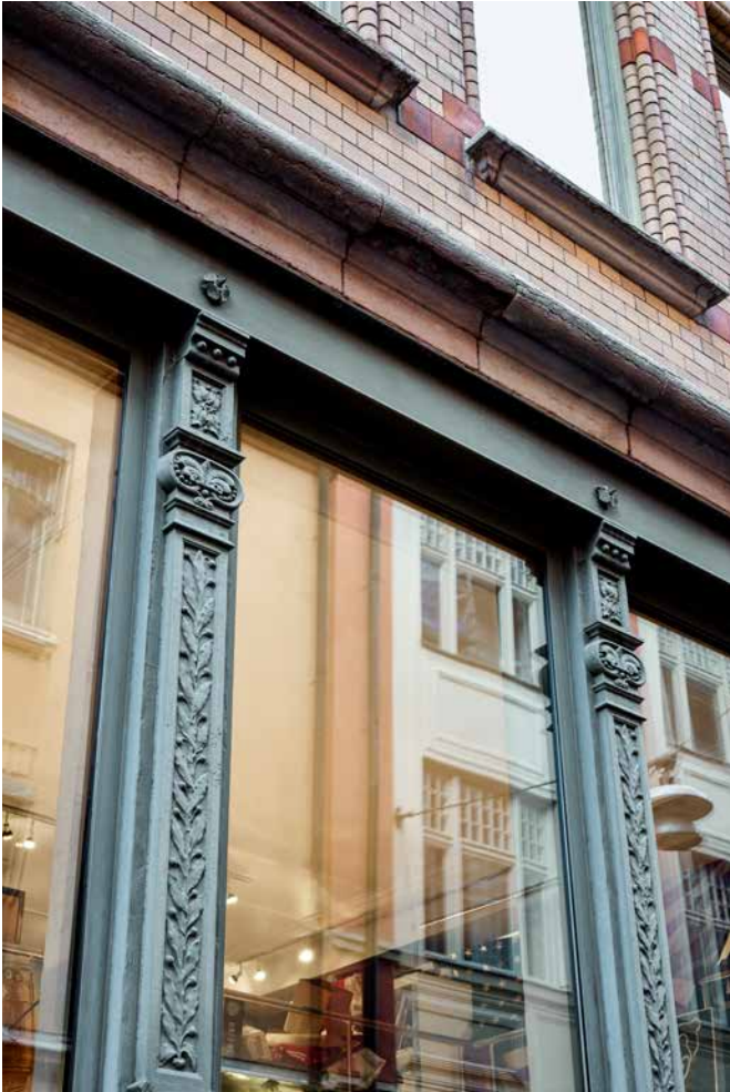
BOKEN 6 BYGGDES 1896 I FÖNSTERSHOPPINGENS BARNDOM. MED SINA VALSADE STÅLBALKAR OCH PELARE AV GJUTJÄRN SKYLTA FÖNSTREN INTE BARA MED VAROR UTAN OCKSÅ MED TOPPMODERN BYGGTEKNIK.
