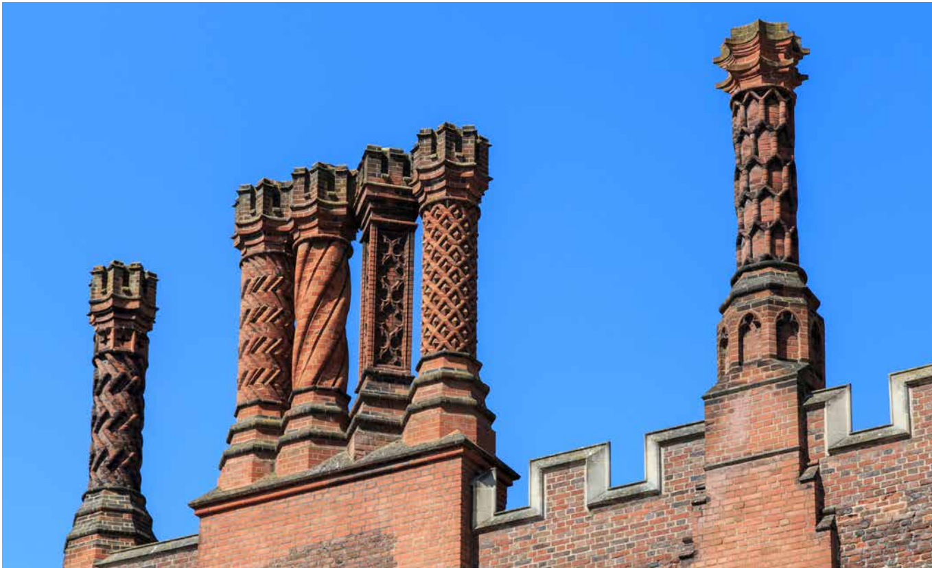
SEX AV HAMPTON COURTS 241 TEGELSKORSTENAR. 1500-TALET MOTSVARIGHET TILL LYXBIL PÅ GARAGEUPPFARTEN.
