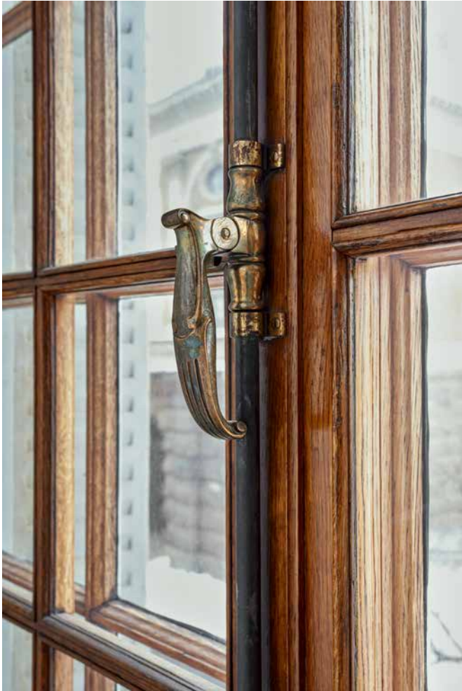
EKFÖNSTREN PÅ JAKOB MINDRE 11 MANÖVRERAS STILFULLT MED SPANJOLETTER AV MÄSSING.
