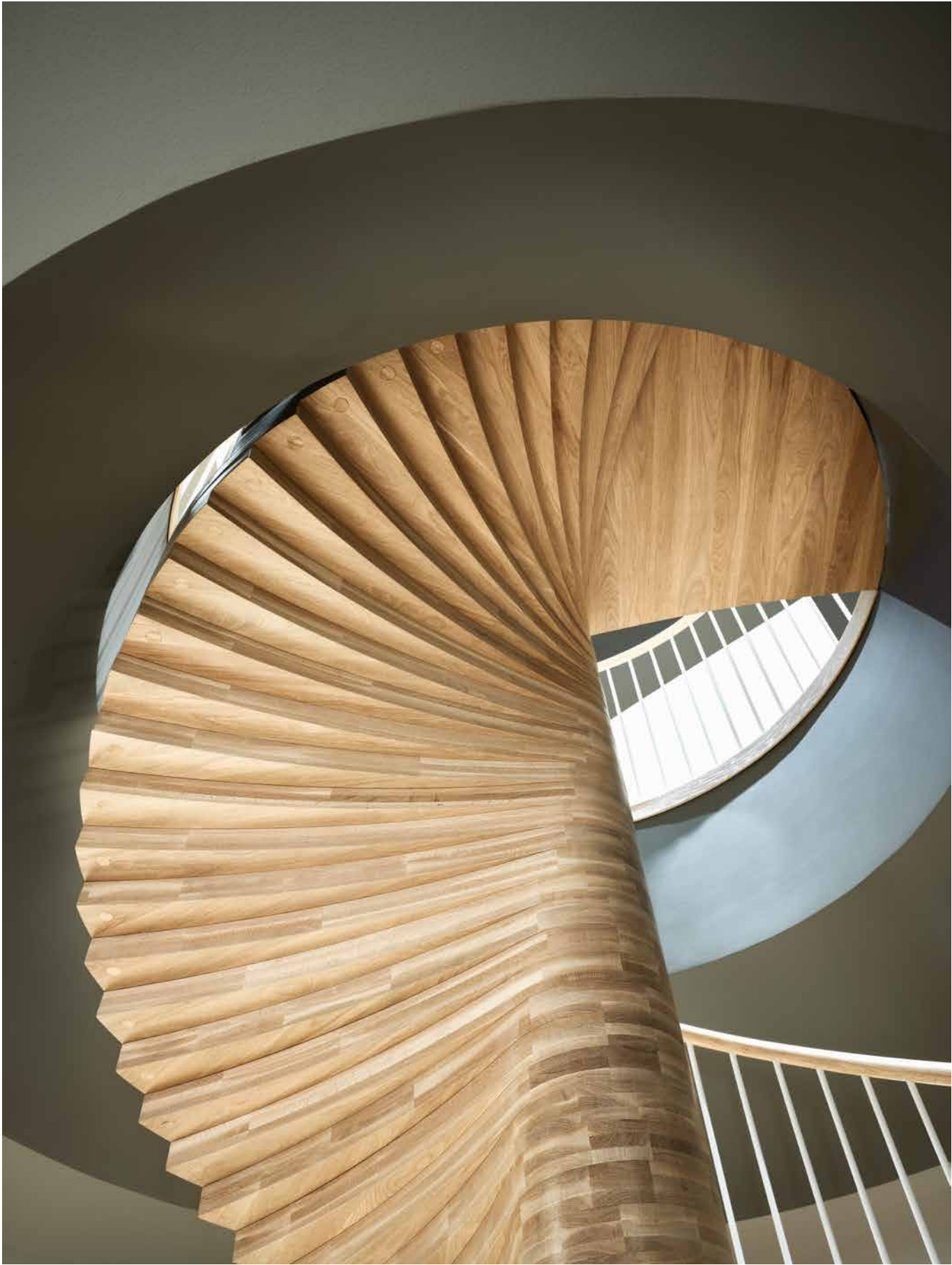
I PILEN 18 PÅ VASAGATAN STÅR SEDAN ETT DRYGT ÅR EN TRAPPA I MASSIV, LÄTT PIGMENTERAD EK. TILLVERKAD AV NORSKA RISA MEYER SOM SPECIALISERAT SIG PÅ SKRÄDDARSYDDA TRÄTRAPPOR.
