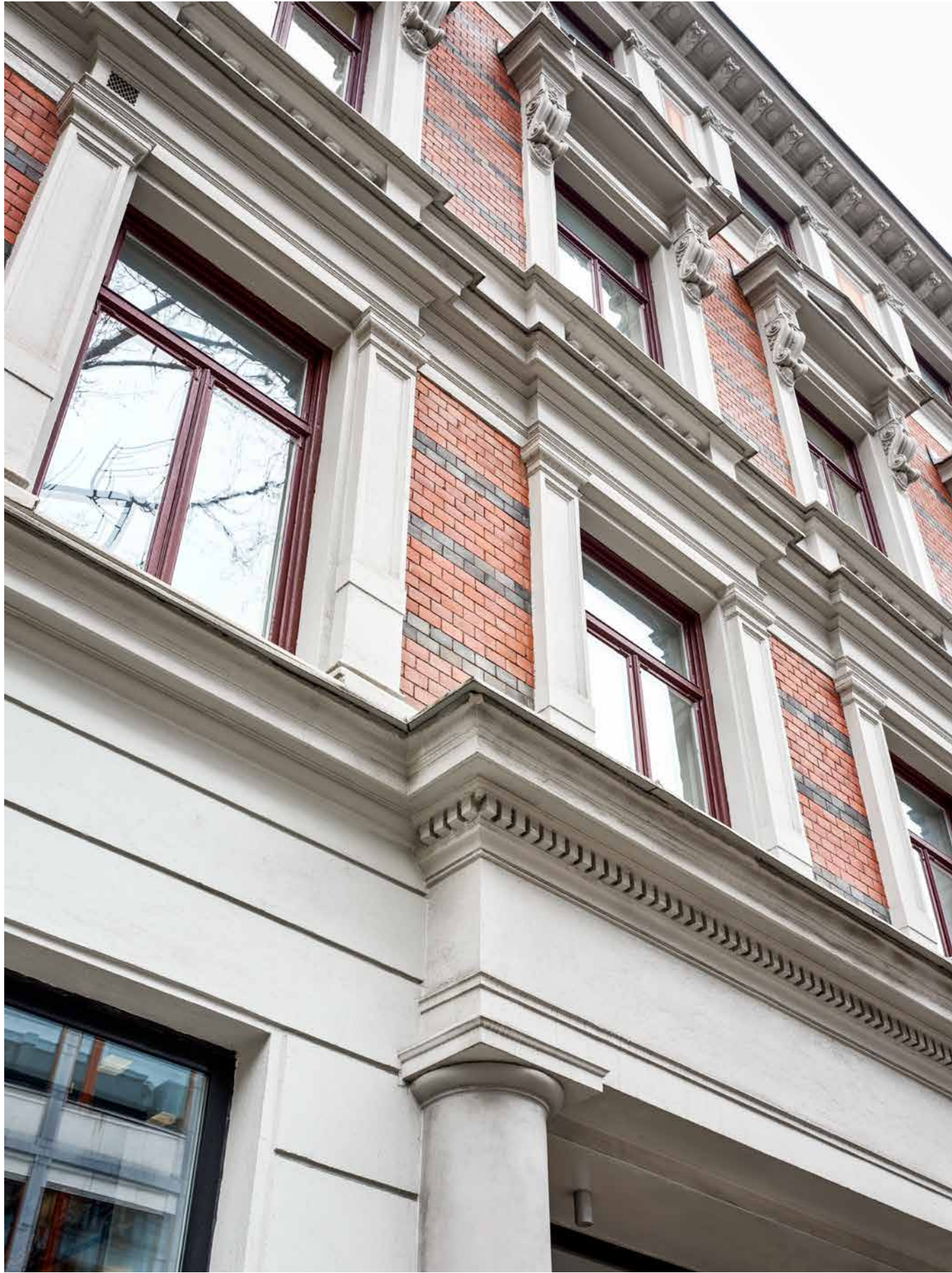
VILDMANNEN 10 ÄR ETT STADSPALATS FRÅN 1885 RITAT AV KASPER SAHLIN. DEN MURADE TEGELSTOMMEN ÄR TÄCKT MED FÖRBLÄNDERTEGEL, EN 3 MM TJOCK FASADSTEN MED VACKERT SINTRAD YTA.
