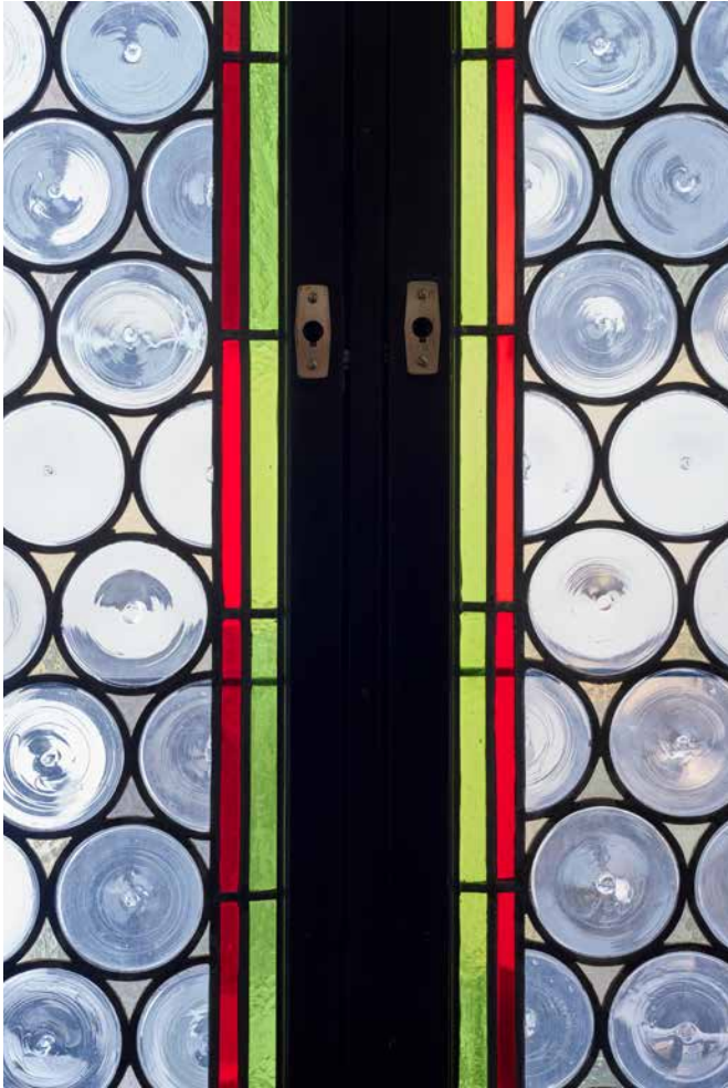
I PHOEBUS 10 SITTER SÅ KALLADE BUTZENSCHIEBEN-FÖNSTER MED BLYSPRÖJSAR OCH RUNDA GLASSKIVOR SOM PÅMINNER OM BUTELJBOTTNAR.
