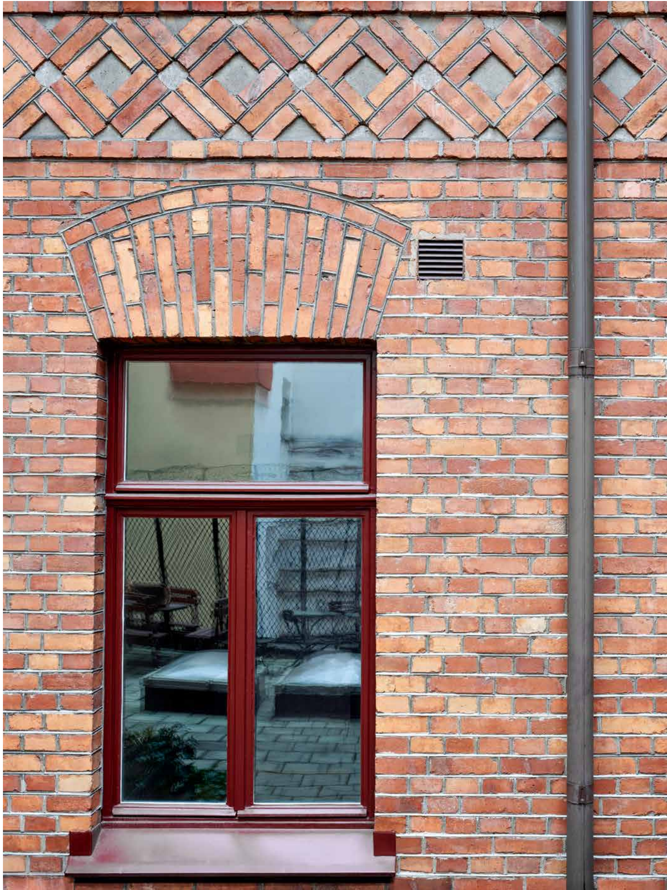
GÅRDSFASADEN PÅ PILEN 18 ÄR ENKLARE ÄN GATUFASADEN MEN ÄNDÅ AMBITIÖS I HANTVERKET MED TEGEL SATT I VENDISKT FÖRBAND. OVAN FÖNSTREN RYSKA VALV OCH MELLAN DEM EN MÖNSTERMURAD FRIS.
