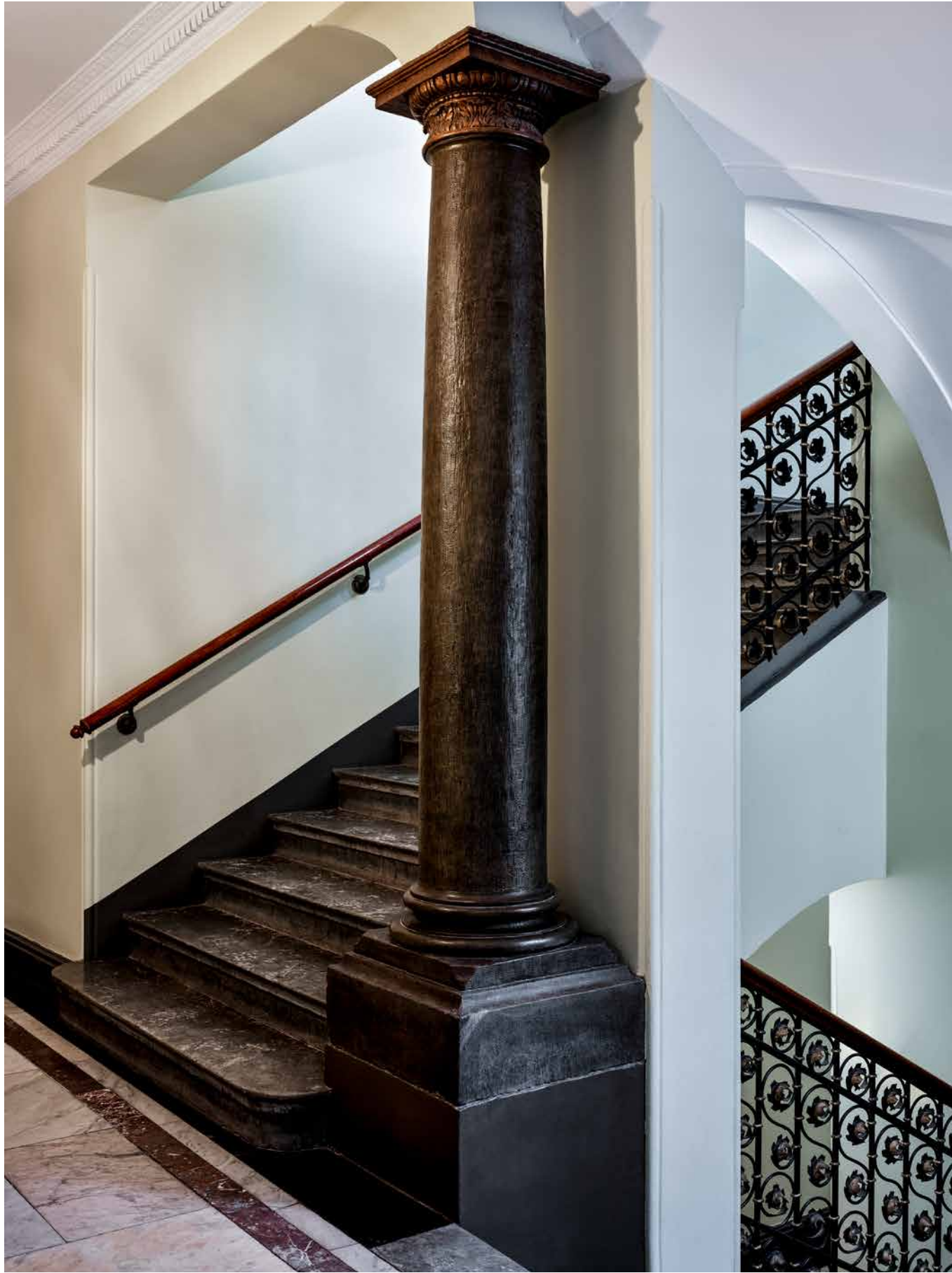
STENKOLONNERN I TRAPPHUSET PÅ PHOEBUS 10 ÄR MED STOR SANNOLIKHET ORIGINAL FRÅN 1600-TALET. BÅDE BAS, SKAFT OCH KAPITAL ÄR BRONSERADE.
