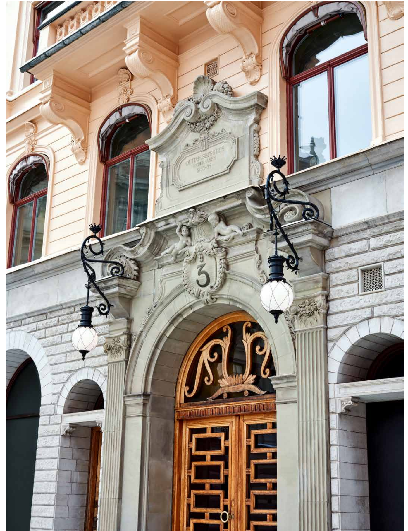
JAKOB MINDRE 5 FICK VID RENOVERINGEN SINA ENTRÉARMATURER FRÅN FÖRRA SEKELSKIFTET ÅTERSKAPADE. MED HJÄLP AV GAMLA FOTON VALDES 35 MILLIMETERS SMITT FYRKANTSJÄRN MED BLADDEKOR I PLÅT.
