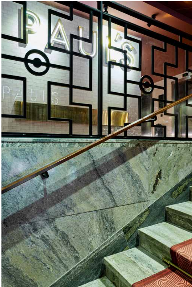
DE KARAKTERISTISKA ART DECO-RÄCKENA I HAYMARKET ÄR NYTILLVERKADE I STÅL UTIFRÅN FOTOGRAFIER AV PUB-VARUHUSETS URSPRUNGLIGA INTERIÖR.
