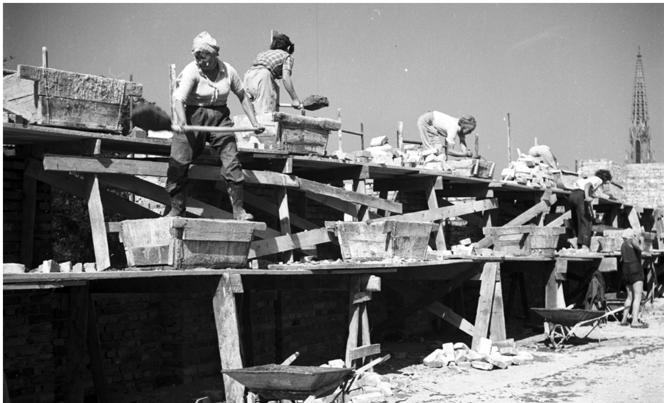
BYGGMATERIALET I BÅDE MARK OCH HUSKROPPAR VAR "GRUZOBETON", EN BLANDNING AV KRÖSSADE RASMASSOR SOM BLEV EN SYMBOL FÖR PLATSENS DUBBELHET AV SORG OCH OPTIMISM.
