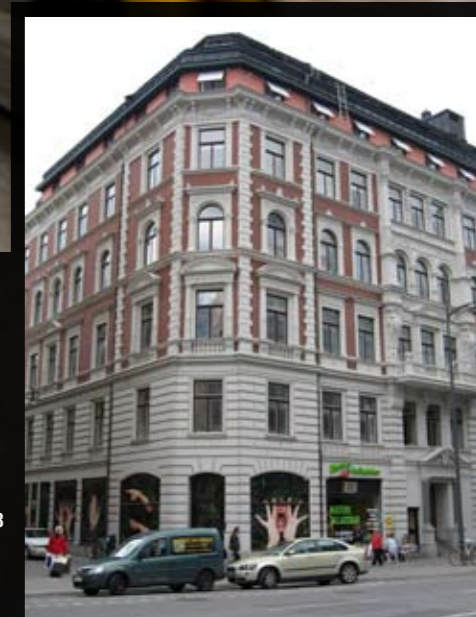
STOCKHOLM | Pilen 18 Kontorsfastighet Adress: Vasagata 40 Total yta: 2 734 kvm
