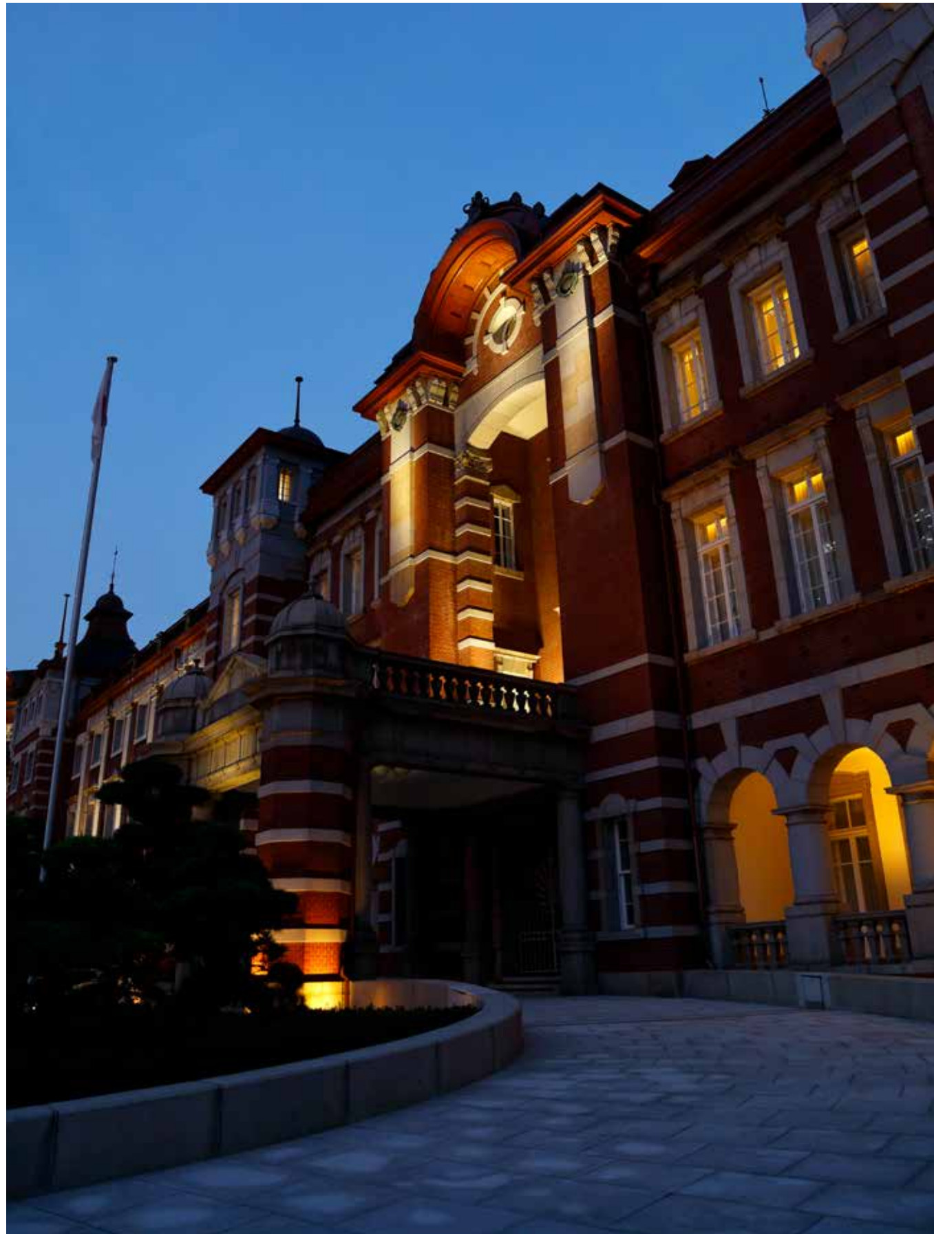
MITSUBISHI HAR, FÖR KANSKE FÖRSTA GÅNGEN I TOKYOS HISTORIA, TAGIT PÅ SIG UPPGIFTEN ATT BEVARA OCH RESTAURERA HISTORISKA MILJÖER. MEST IMPONERANDE ÄR TOKYO STATION, URSPRUNGLIGEN BYGGD 1914 SOM EN KOPIA PÅ CENTRALSTATIONEN I AMSTERDAM. TOKYO STATION SKADADES SVÅRT UNDER KRIGET OCH ÖVERSTA VÅNINGEN MED DESS KUPOLER HAR NU ÅTERSKAPATS I SIN URSPRUNGLIGA PRAKT.
