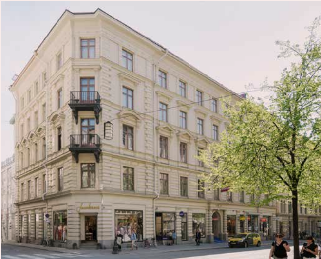
BRYGGMÄSTAREN 5 KUNGSGATAN 53, GAMLA BROGATAN 30-32
