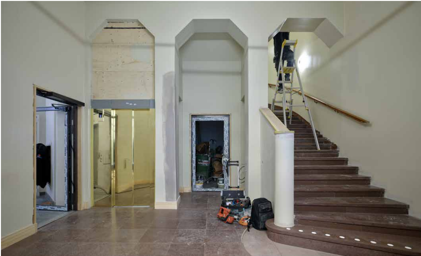
LAGER AV FÄRG OCH SLITNA STEG VITTNAR OM ALLA SOM GÅTT I TRAPPHUSET FÖRE OSS. MEN ÄVEN I TAKEN FINNS DETALJER SOM AVSLÖJAR DET FÖRFLUTNA. BAKOM DET TIDIGARE NEDSÄNKTA TAKET I FASTIGHETEN VINKELHAKEN DOLDDES TRE VACKRA VALV.
